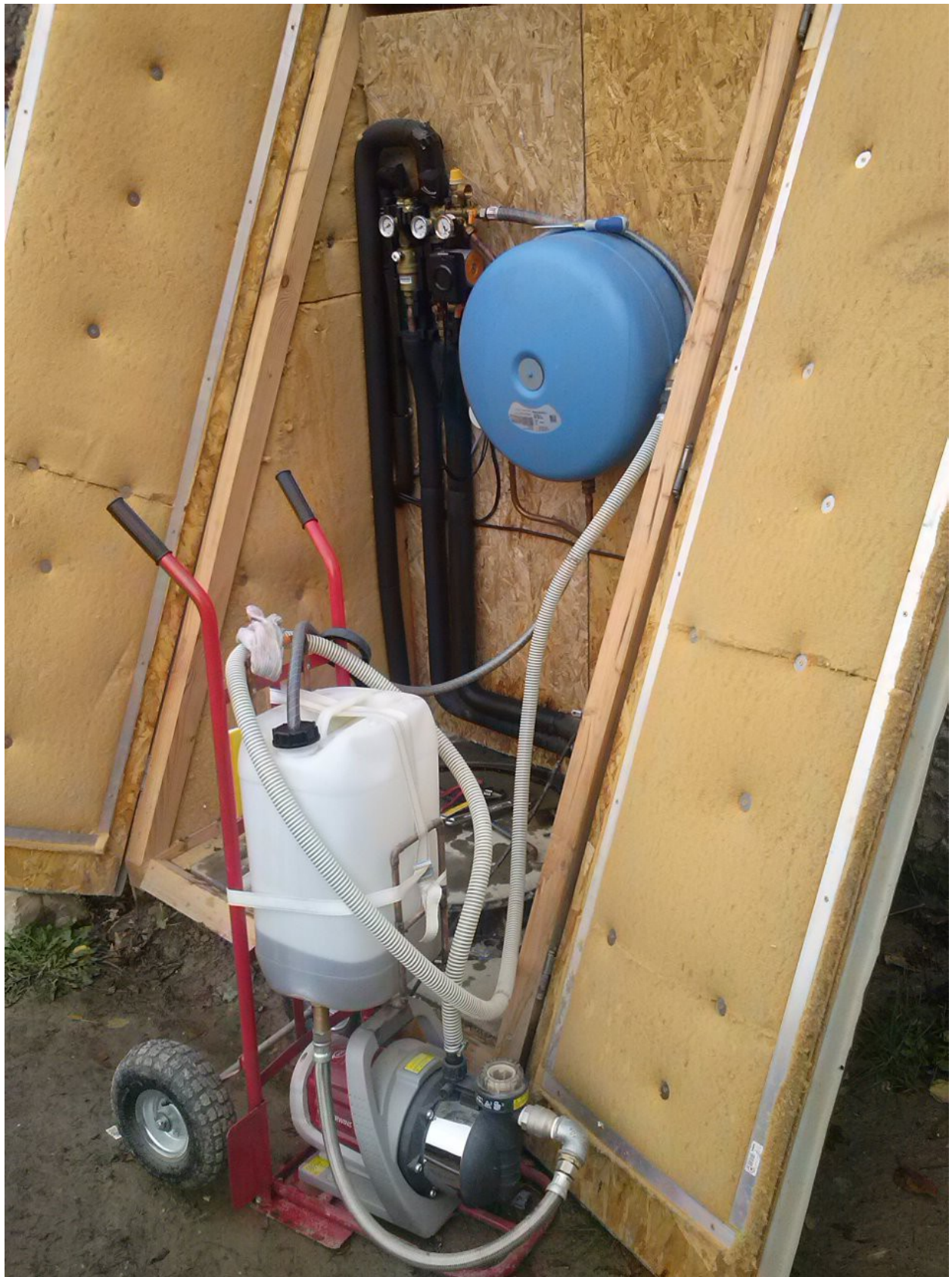
système de remplissage et purge auto-construit au Gabion
